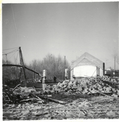
U 16. Stubinfabrik Brandmur A.9049
