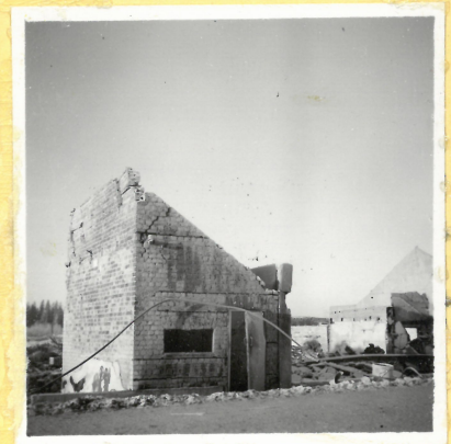
U 9 från sydost. Kvar- stående brandmur. A 9054
