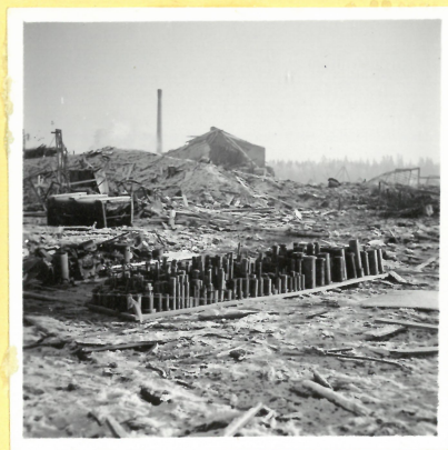
S 1. och ångcentralen G 4. sedda från taket av U 7. (svarvningsavdelningen).
