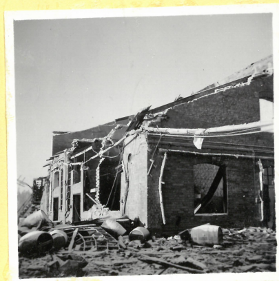
S 1. sett från sydost. A.9073
