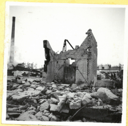
Brandmur i U 9. mot nordost.
